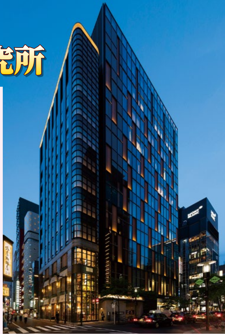
東京支店が入居するビル「Brown Place」
